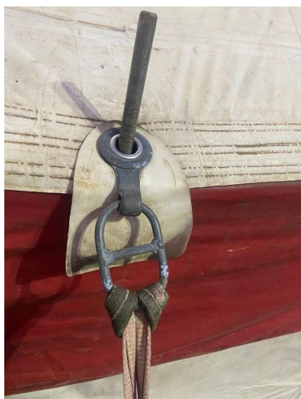
Figura 2 | Foto do sistema de ancoragem da borda inferior.
